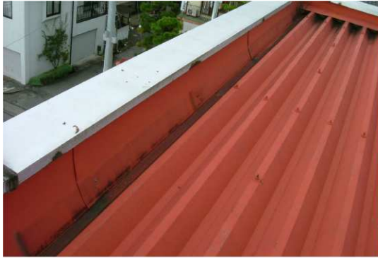
ケラバ既存状況写真
